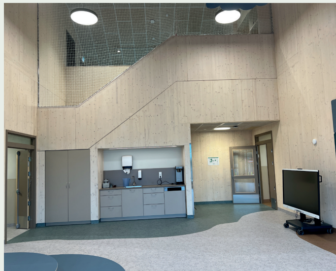
Bruken av massivtreelementer er godt synlig inne i barnehagen
