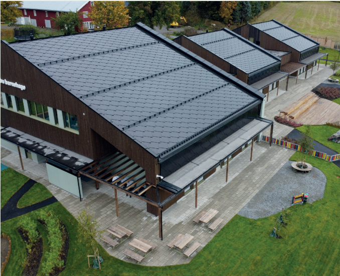
Både tak og deler av veggene har integrerte solcellepanel.
